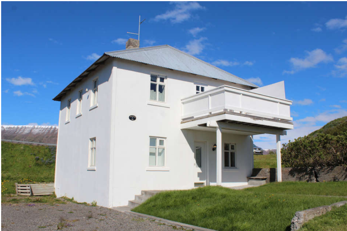
Mynd 25. Svalbarð byggt árið 1930. SFA, 2017.
