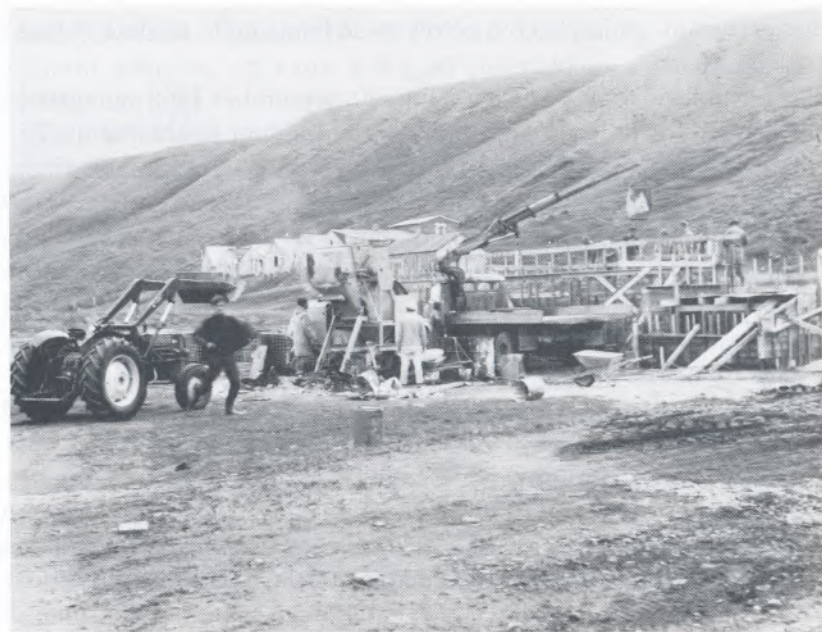
Steypuvinna við grunnplötu Safnahússins sumarið 1965. Valgeir Guðjónsson á Daufá hífði alla steypu í húsið með kranabíl sínum. Ljós.: Kristján C. Magnússon.
